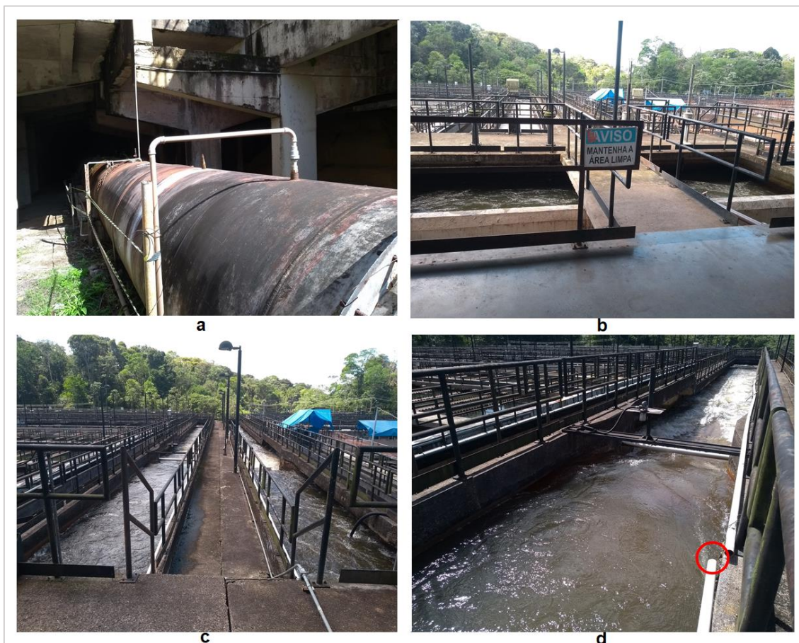
Figura 9 – Ponto de aplicação do coagulante – PAC (a), câmara de chegada (b), calhas Parshall (c) e ponto de aplicação do polímero de poliacrilamida (d). Fonte: Chaves, 2020.
